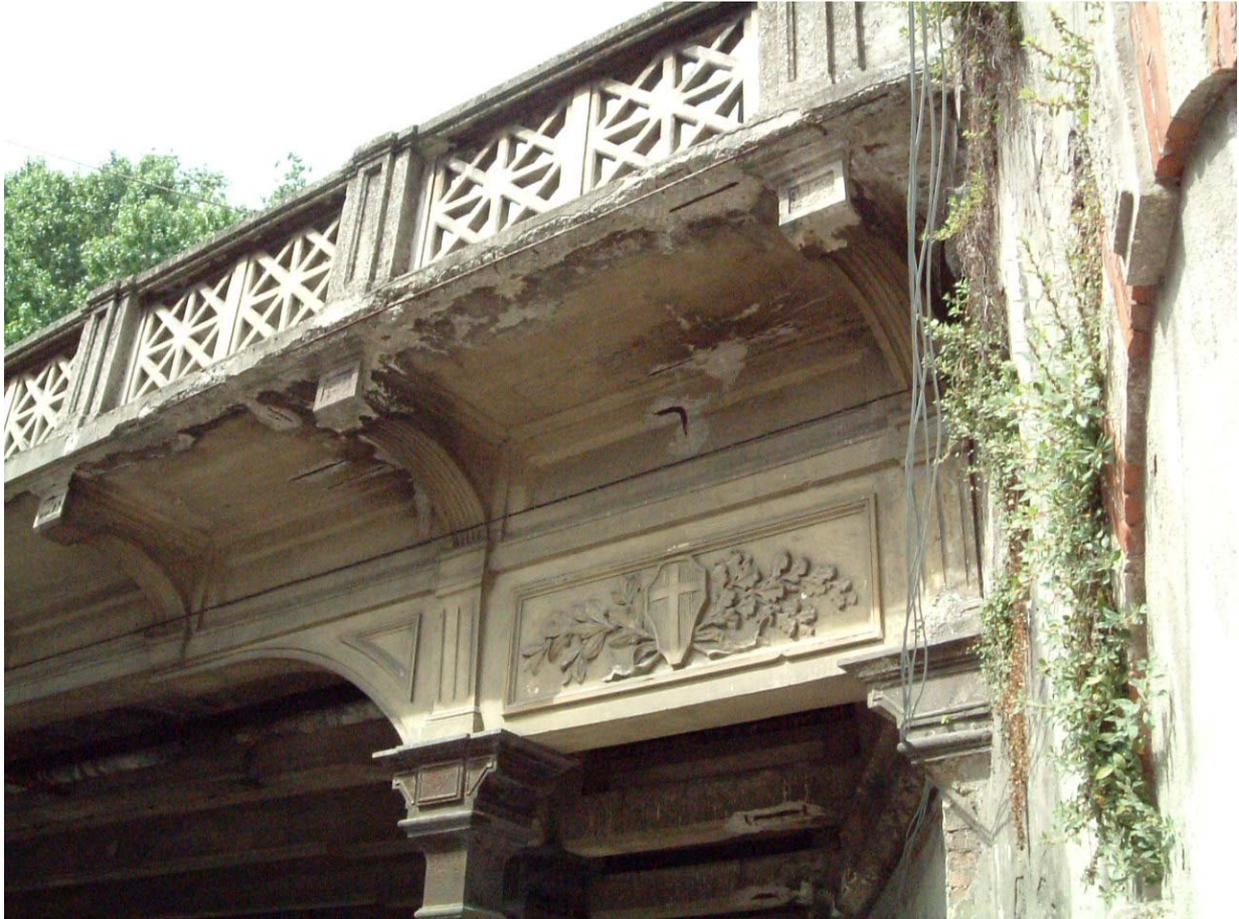
Figura 15.c: Vista ai bordi del ponte. Il ponte è obliquo. L'obliquità determina una lunghezza complessiva di 14.66 m, laddove la distanza reciproca tra i muri delle spalle è di 12.16 m.
