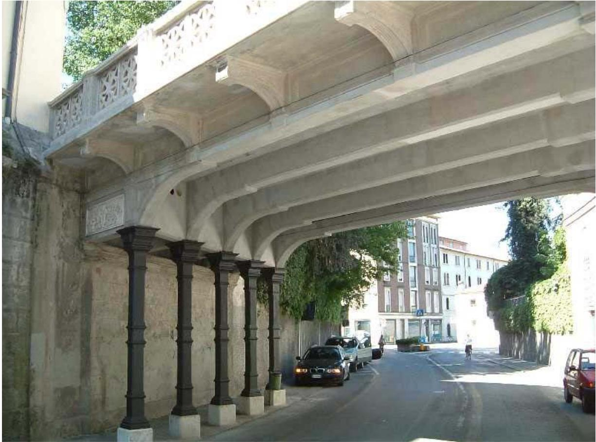
Figura 15.h: Vista del ponte ad intervento finito. La ricostituzione delle sezioni ha riportato il ponte nella sua condizione estetica primigenia. Si noti in particolare l'assenza di tracce rivelatrici della presenza dei rinforzi.
