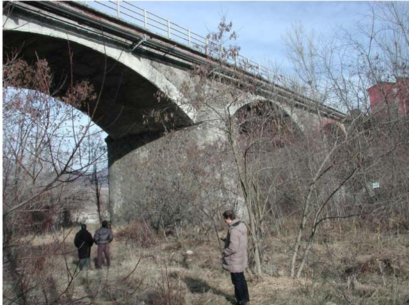
Figura 37: Ponte Locatelo. Il ponte richiede l'allargamento della carreggiata. Un intervento di adeguamento statico è necessario per supportare l'allargamento. Il ponte richiede anche l'adeguamento sismico.
