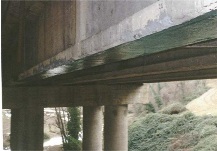
Figura 13.1: Impalcato di un ponte autostradale in C.A. adeguato mediante rinforzi in materiale composito. L'intervento è stato eseguito nel 1997. Trattasi quindi, in Italia, di un intervento pilota.
