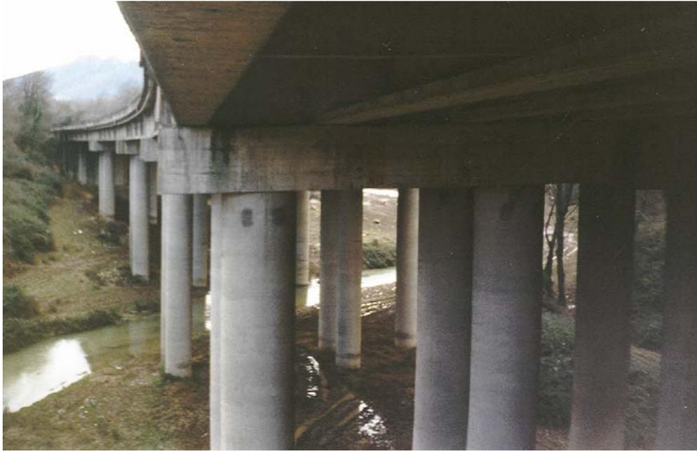
Figura 13.3: Vista di un ponte autostradale. La portanza dell'impalcato non poteva portare in sicurezza il sovrappeso dato dall'adeguamento delle barriere di protezione laterale. L'impalcato è stato adeguato ai nuovi carichi permanenti incollando un'armatura esterna in composito.
