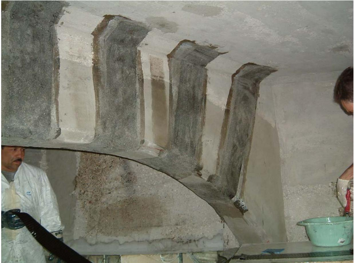
Figura 15.e: Rinforzi radiali della II fase, atti ad incrementare la portanza a taglio. Preparazione delle superfici di cls ed applicazione dei nastri.
