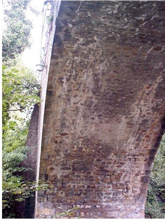
Figura 41: Altro ponte sulla SP 60. Il ponte è stato adeguato funzionalmente. L'adeguamento nunzionale ha richiesto l'adeguamento statico e sismico. L'intervento è stato improntato in composito.
