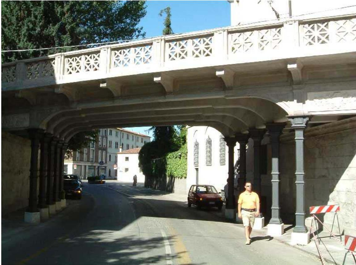
Figura 15.a: Ponte in C.A. storico. L'opera è stata realizzata nella metà del XIX secolo. Il ponte è destinato alla I categoria, e così è usato. Le verifiche preliminari hanno dimostrato che il ponte non è ascrivibile alla I categoria; ovvero che, usato come ponte di I categoria, garantisce una sicurezza marcatamente inferiore a quella prescritta dalle normative, pur non rappresentando un pericolo imminente.
