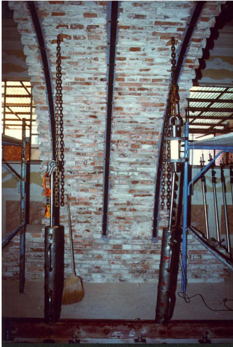
Figura 24.a: Il rinforzo consiste in tre lamine della larghezza di 50 mm ciascuna, incollate sull'intero intradosso. L'applicazione di lamine (le quali hanno una rigidità non evanescente) su una superficie curva ha richiesto, in fase d'incollaggio, l'uso di pennini di fissaggio. I pennini non lasciano traccia alcuna (peraltro qui non sono stati tolti), ma aumentano un po' gli oneri di posa.
