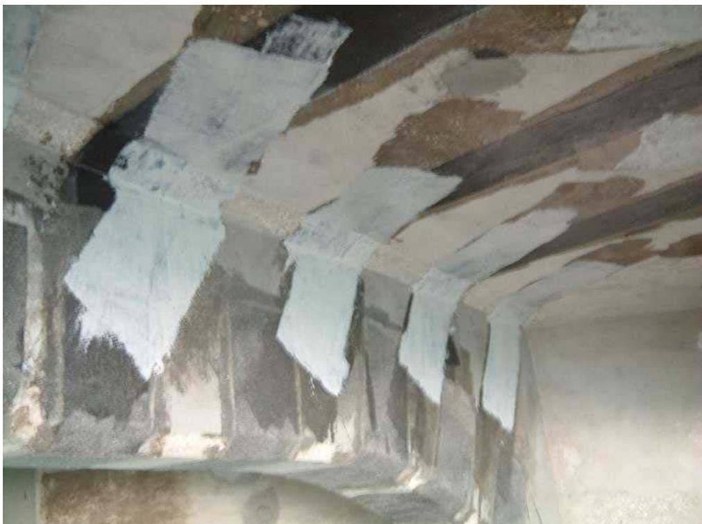
Figura 15.g: Rinforzi obliqui della IV e della V fase, atti ad incrementare la resistenza a scorrimento della soletta rispetto alla trave e ad enfatizzare l'aderenza del sistema di rinforzo.
