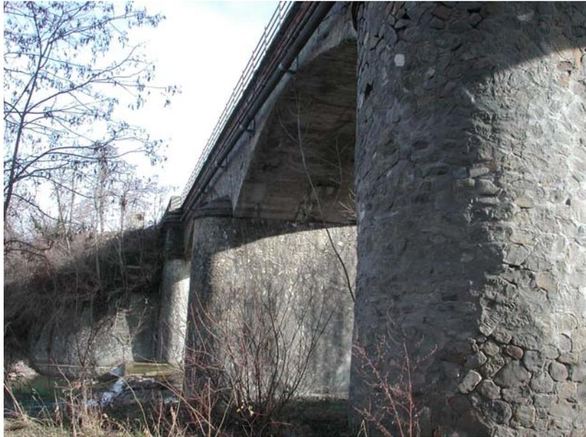
Figura 38: Vista intradossale di Ponte Locatello. L'intervento di adeguamento sismico prevede (1) pali infissi dalla carreggiata (estradosso pile) sino a penetrare il terreno fondale per qualche metro, (2) nastri e pioli in composito all'intradosso degli archi, (3) nastri in composito sulla testa e alla base delle pile.
