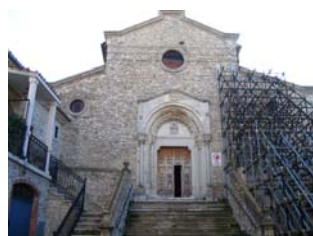
Figura 1a. Facciata della chiesa all'apertura del cantiere.
