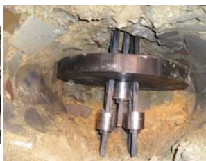
Figura 29b. Fase di montaggio dei trefoli: applicazione dell'ancoraggio alla base.
