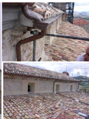
Figura 1g. Copertura. Due diverse immagini scattate durante i lavori.
