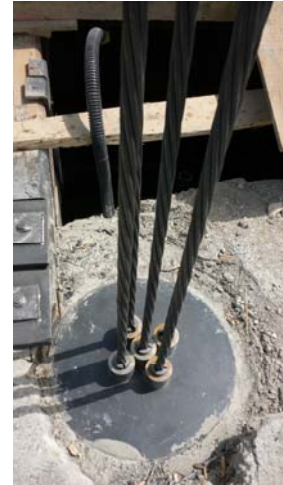
Figura 22. Vista dei 5 trefoli verticali, con le boccole di ancoraggio.
