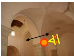
Figura 28b. Vincolo fornito dalle crociere: impedisce la traslazione della testa delle colonne. SLD è stato rispettato.
