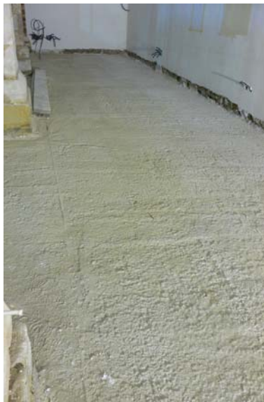
Figura 17. Soletta di C.A. contro terra. La soletta è cucita ai muri perimetrali mediante barre d'acciaio, annegate nel getto e inghisate nella muratura.
