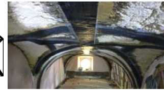
Figura 25. Rinforzi in CFRP incollati all'intradosso delle volte a crociera, larghi 20 cm.
