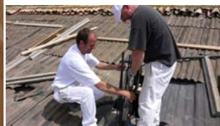
Figura 29a. Pre-tesatura dei trefoli: 1150 kN a cavo. Così lo SLD è stato rispettato.
