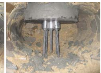
Figura 29c. Ancoraggio dei trefoli sotto la base delle colonne murarie della chiesa.
