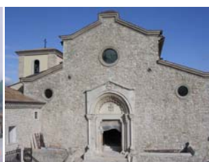
Figura 1c. Facciata: aprile 2007, fine lavori strutturali.
