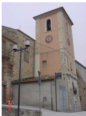
Figura 1f. Torre civica. La sua interazione con la chiesa è stata nociva (torsioni parassite.)
