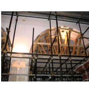
Figura 3. Opere provvisorie della somma urgenza post-sismica. Lo sciame sismico aveva messo in carico anche i puntelli che erano stati messi in opera laschi.
